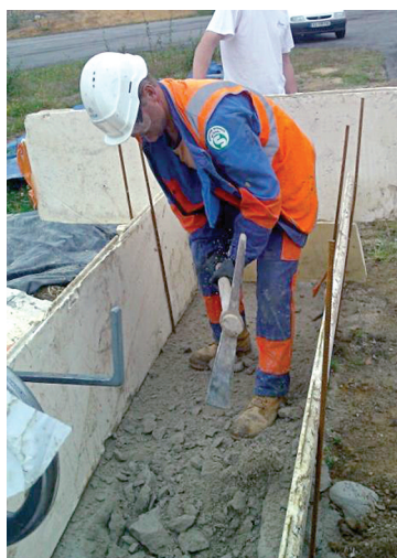
Figure 2 Piochage sur des tranchées, les panneaux de polystyrène latéraux permettant de ne pas perdre de matière par projection lors de l'impact de la pioche
